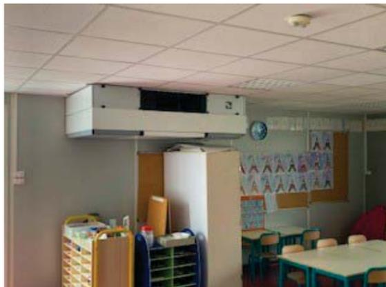
Cet été, l'école maternelle l'Oiseau de Feu a subi quelques transformations avec le remplacement du sol du hall (travaux réalisés par l'entreprise ABBEI) mais aussi la pose d'une centrale d'air dans la classe bleue afin de filtrer et purifier l'air de celle-ci (travaux réalisés par IDEX).
